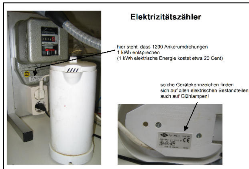
Abbildung 5.7: Station: Stromzähler beim Wasserkocher.
